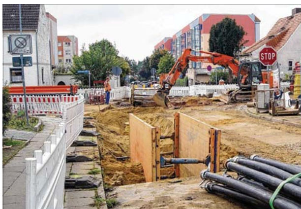
An der Kreuzung werden die Anschlüsse an den Vorfluter installiert.
