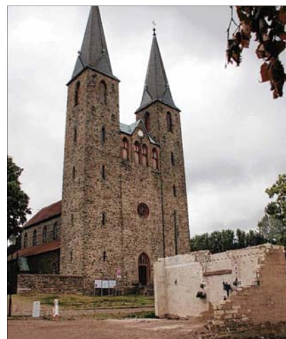
Nach dem Abriss des ehemaligen Schulungsraumes erfolgt demnächst der Baubeginn für das Hillersleber Bürgerhaus. Foto: Steffen
