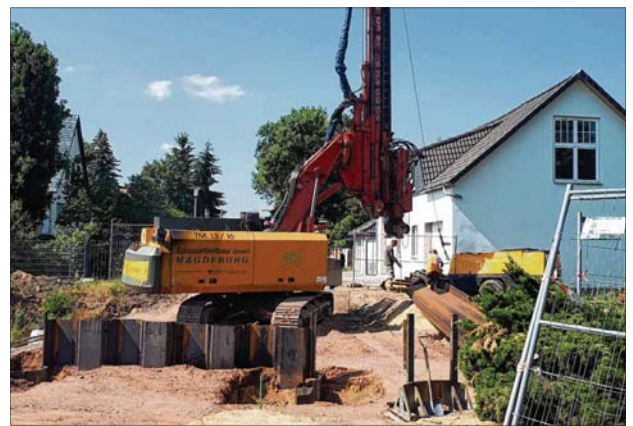
Schweres Gerät kam jüngst an der Brückenbaustelle in der Straße „Zum Schloss“ zum Einsatz, um die Spundwände zu setzen. Foto: privat / Rainer Totzke
