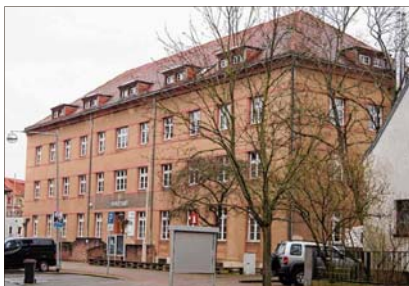
Ende Juni soll das Landratsamt in der Farsleber Straße leer sein. Das landkreiseigene Gebäude soll verkauft werden. Foto: Billowie
