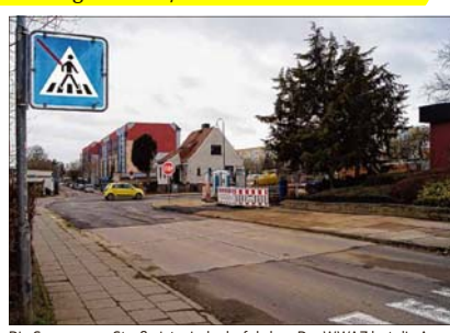
Die Samswegger Straße ist wieder befahrbar. Der WWAZ hat die Arbeiten termingerecht abgeschlossen. Foto: Gudrun Billowie
